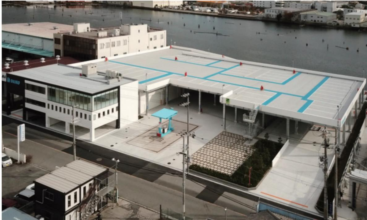
大型立体駐車場・自家給油所・整備工場・事務所棟で構成され、緊急時には高さ6m以上を避難場所とします。
