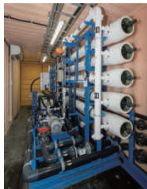
RO（浸透）膜を連ねた海水淡水化装置。処理水槽の水が一定量減ると自動的に稼働する仕組みです
