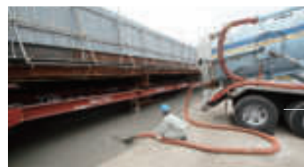
施工性に優れたリサイクル埋め戻し材「ポリソイル」
