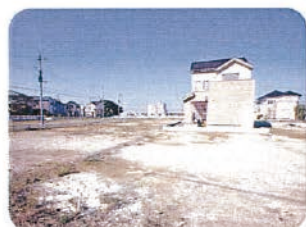
軟弱土壌改良工事
