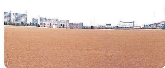
グラウンド改良工事
