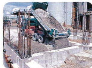
建設工事の埋戻し
