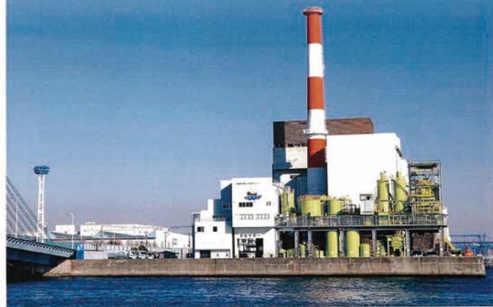
(かもめ大橋対岸より、南港処理センターを望む) ※背景の遠くの建造物は大阪市堺橋
