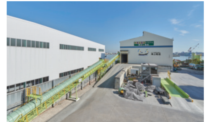
製品保管倉庫へ再生土を運ぶベルトコンベア
