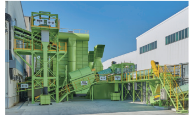
固化再生施設(屋外部分)
