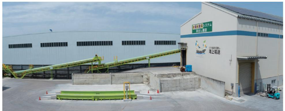
製造設備から製品保管倉庫へ再生土を運ぶベルトコンベア
