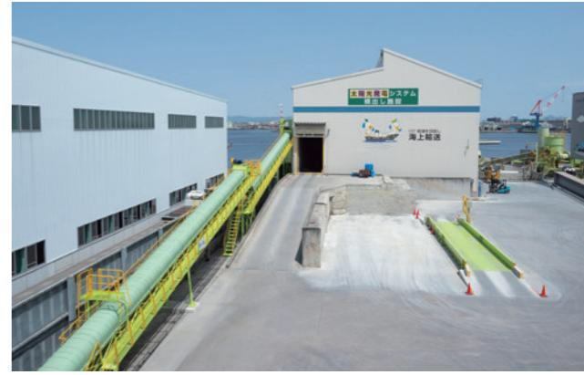
製品保管倉庫へ再生土を運ぶベルトコンベア
