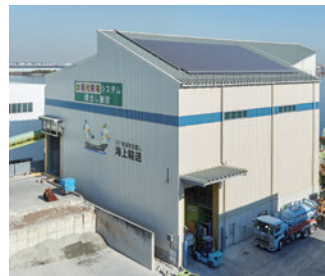
製品保管倉庫とソーラーパネル
