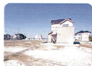
軟弱土壌改良工事
