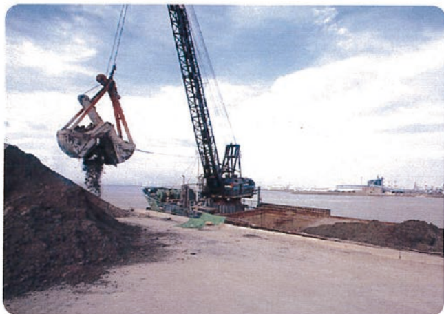
(フェニックス埋立処分場の覆土)荷揚げ作業
