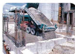
建設工事の埋戻し
