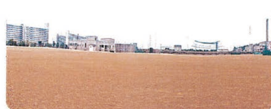
グラウンド改良工事
