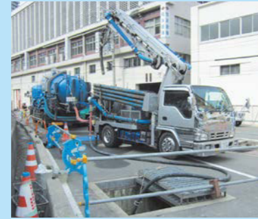
埋設管内部へのポンプ車 打設
