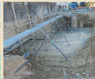
打設後ドライアップ確認
