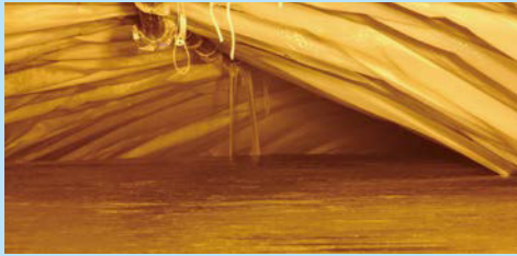
廃棄山岳トンネルの埋戻し
