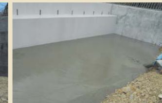
橋台背面の打設
