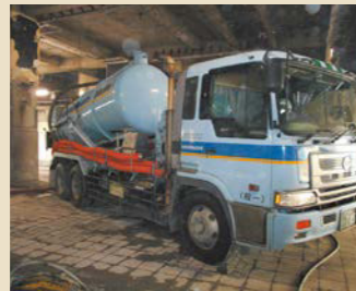
ダンプアップとブロー打設
