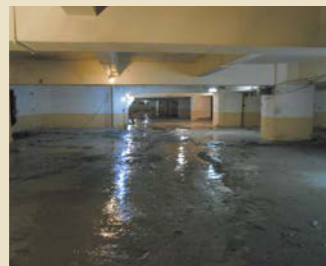
地下室内埋戻し状況
