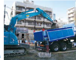
お客様の現場から発生した建設汚泥等
