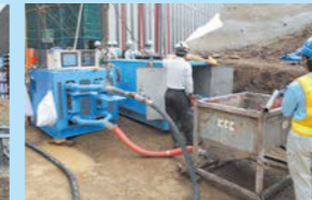
中継ポンプの使用
