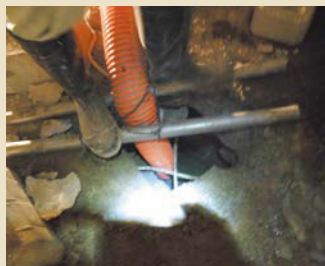
スラブよりの打設
