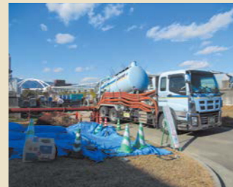
トレミー管によるブローア車 打設
