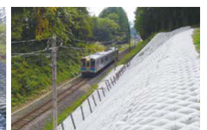
写真は、旭化成アドバンス(株)提供のモルタル注入タイプの「ファブリフォーム®※7」AA51H093
