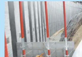
構造物側部型枠内の埋戻し
