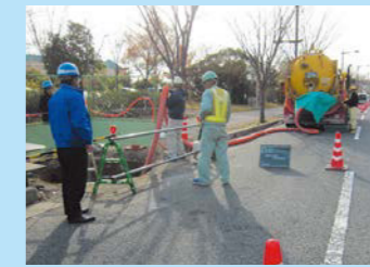
ブローア車 打設
