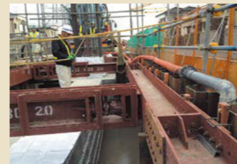
鉄道高架橋基礎部へのブローア車 打設
