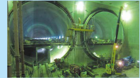
シールド断面 全景
