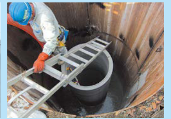
マンホール側部への打設
