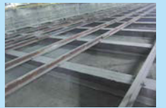
インバート部の打設後
