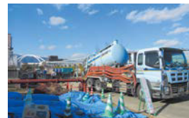
フロー車 打設
