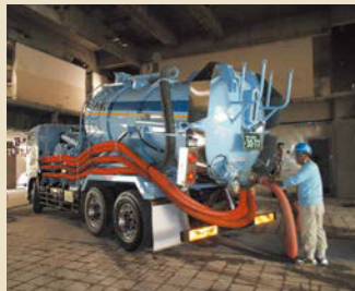
建物地下室へのブローア車 打設
