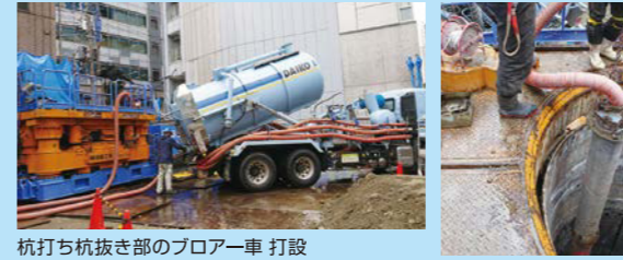
杭打ち杭抜き部のブローア車 打設
