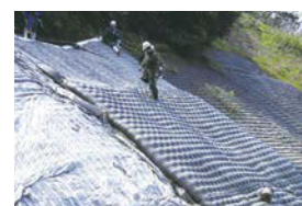
写真は、旭化成アドバンス(株)提供のモルタル注入タイプの「ファブリフォーム®※7」AA51H093
