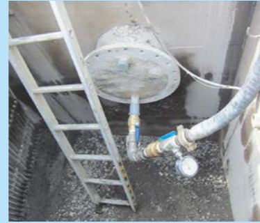
下水管内部への配管
