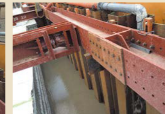
地中梁側部への打設
