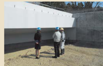
橋台背面埋戻し前
