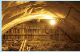
トンネル内に設置した型枠
