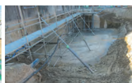
打設後 ドライアップ確認
