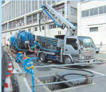
埋設管内部へのポンプ車 打設
