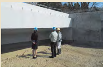
橋台背面埋戻し前
