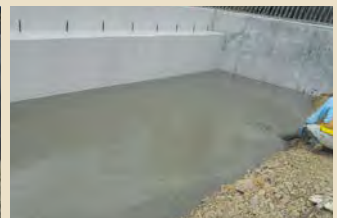
橋台背面の打設
