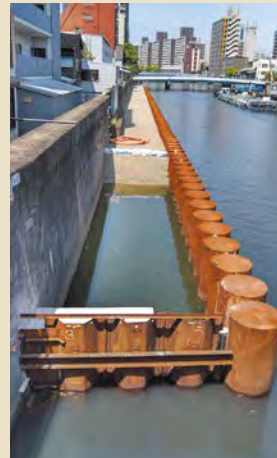
護岸内施工前
