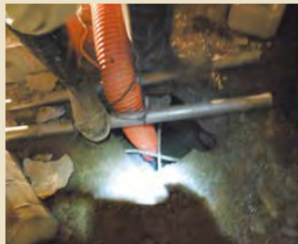
スラブよりの打設
