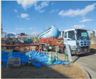
トレミー管によるブローアーク 打設
