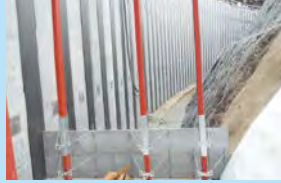
構造物側部型枠内の埋戻し
