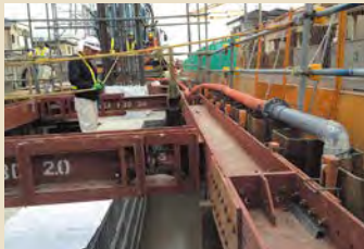
鉄道高架橋基礎部へのブローアーク 打設
