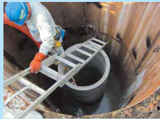
マンホール側部への打設
