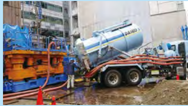
杭打ち杭抜き部のブローアーク 打設
