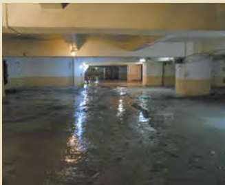
地下室内埋戻し状況
