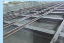
インバート部の打設後
