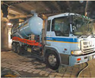
ダンプアップとブロー打設
