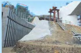
高速道路工事埋戻し
