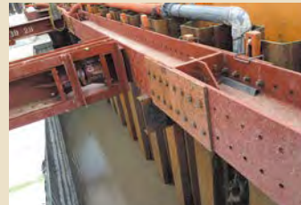
地中梁側部への打設
