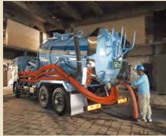
建物地下室へのブローアーク 打設
