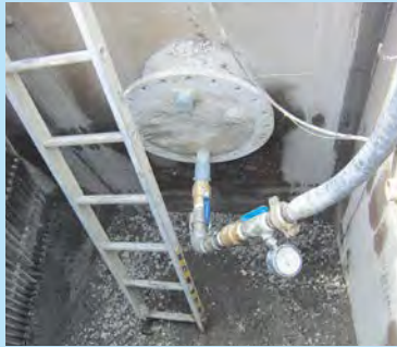
下水管内部への配管
