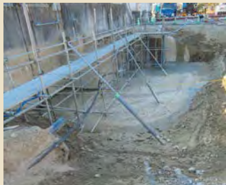
打設後ドライアップ確認
