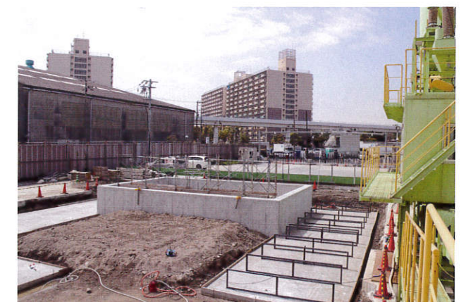
大阪ベントナイト南港東プラント 工事中の第4貯木場専用の受け入れピット
