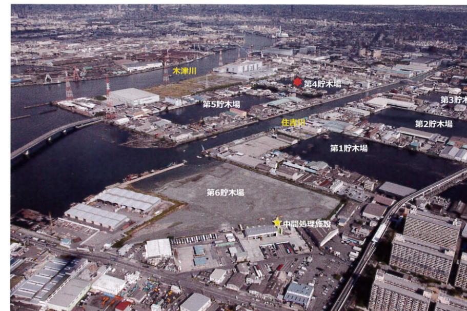
第6貯木場にある大阪ベントナイト南港東プラントと第4貯木場
