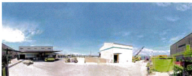
新しくなった堺プラント
