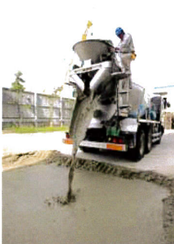
流動化処理土(ポリソイル)
