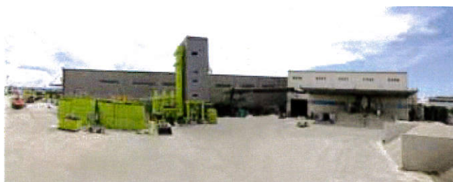
建設汚泥再資源化施設(流動化処理土製造施設)
