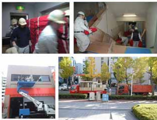
揚重部門工事の一例
