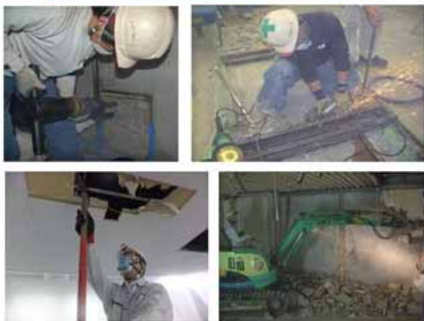
解体部門工事の一例
